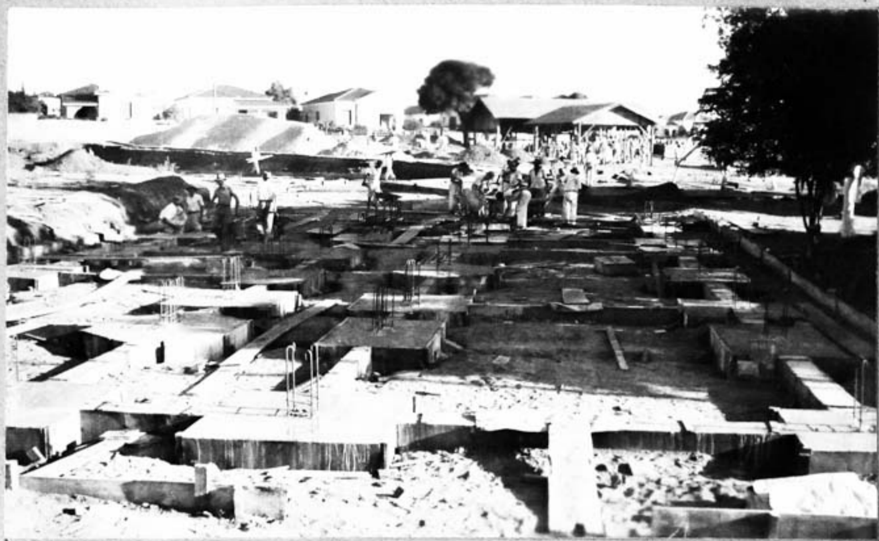
Foto 10- Corpo II- Concretagem da base
