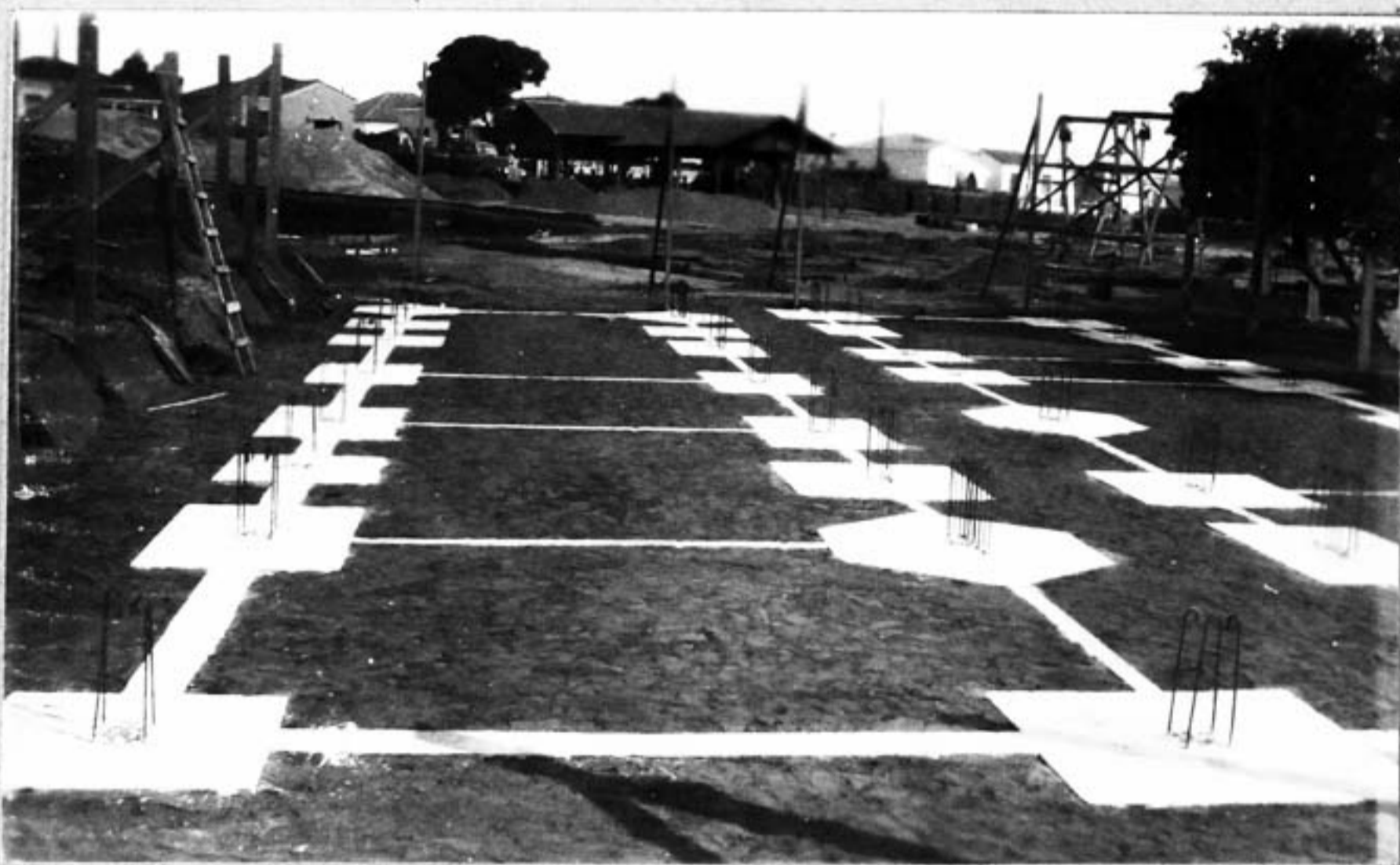
Foto 11- Corpo II- Base concretada
