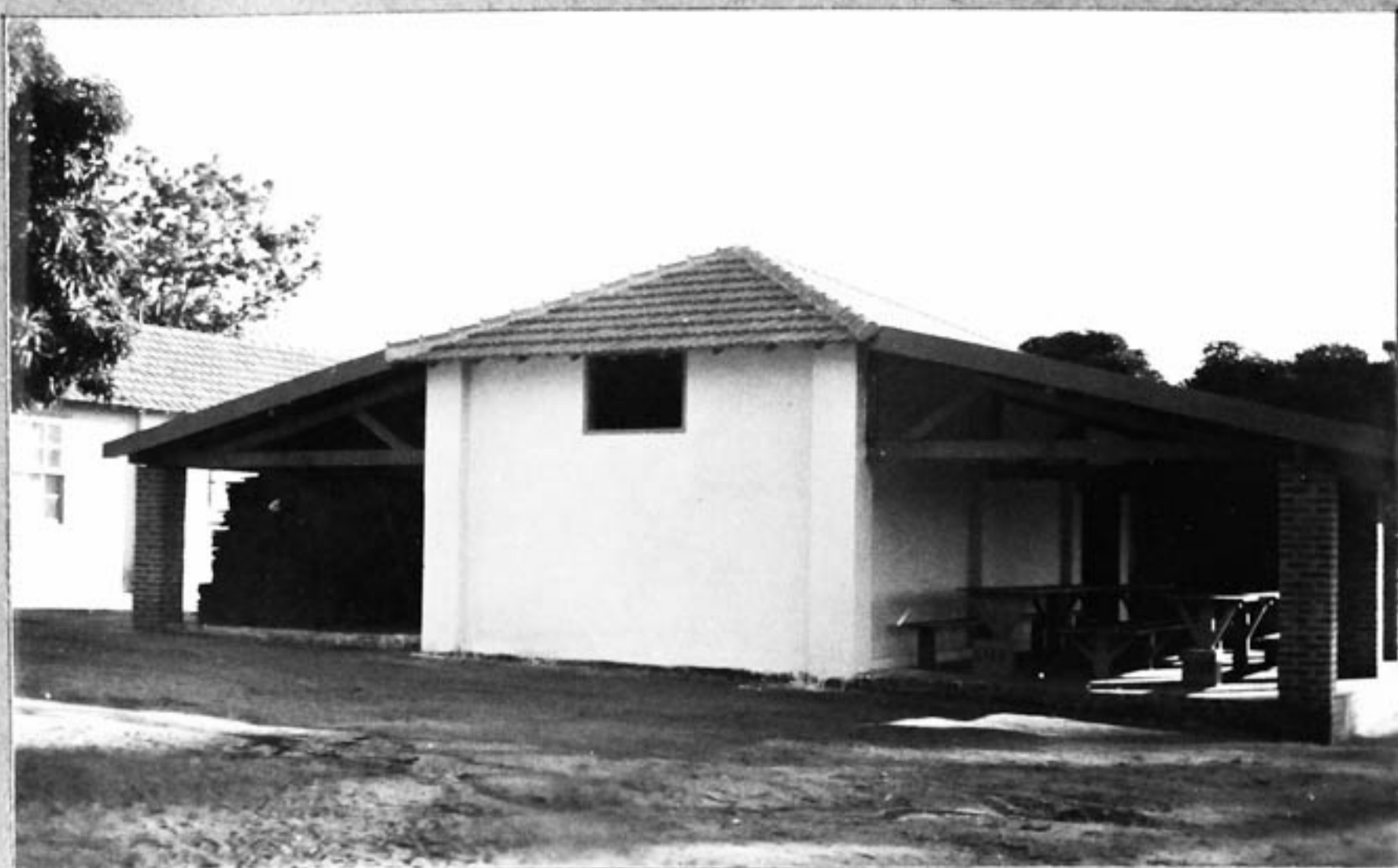
Foto 1- 2º Almoxarifado e refeitório
