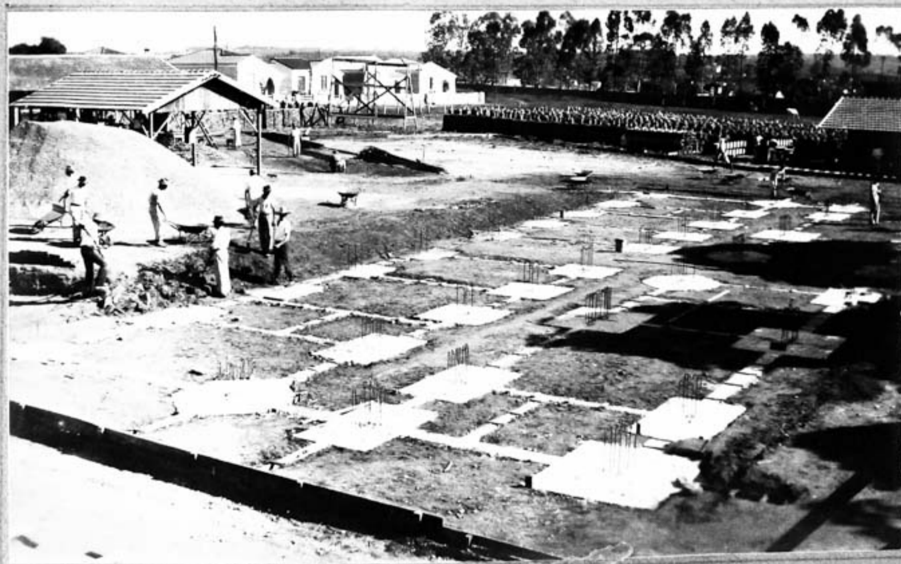
Foto 12- Corpo IV- Base concretada
