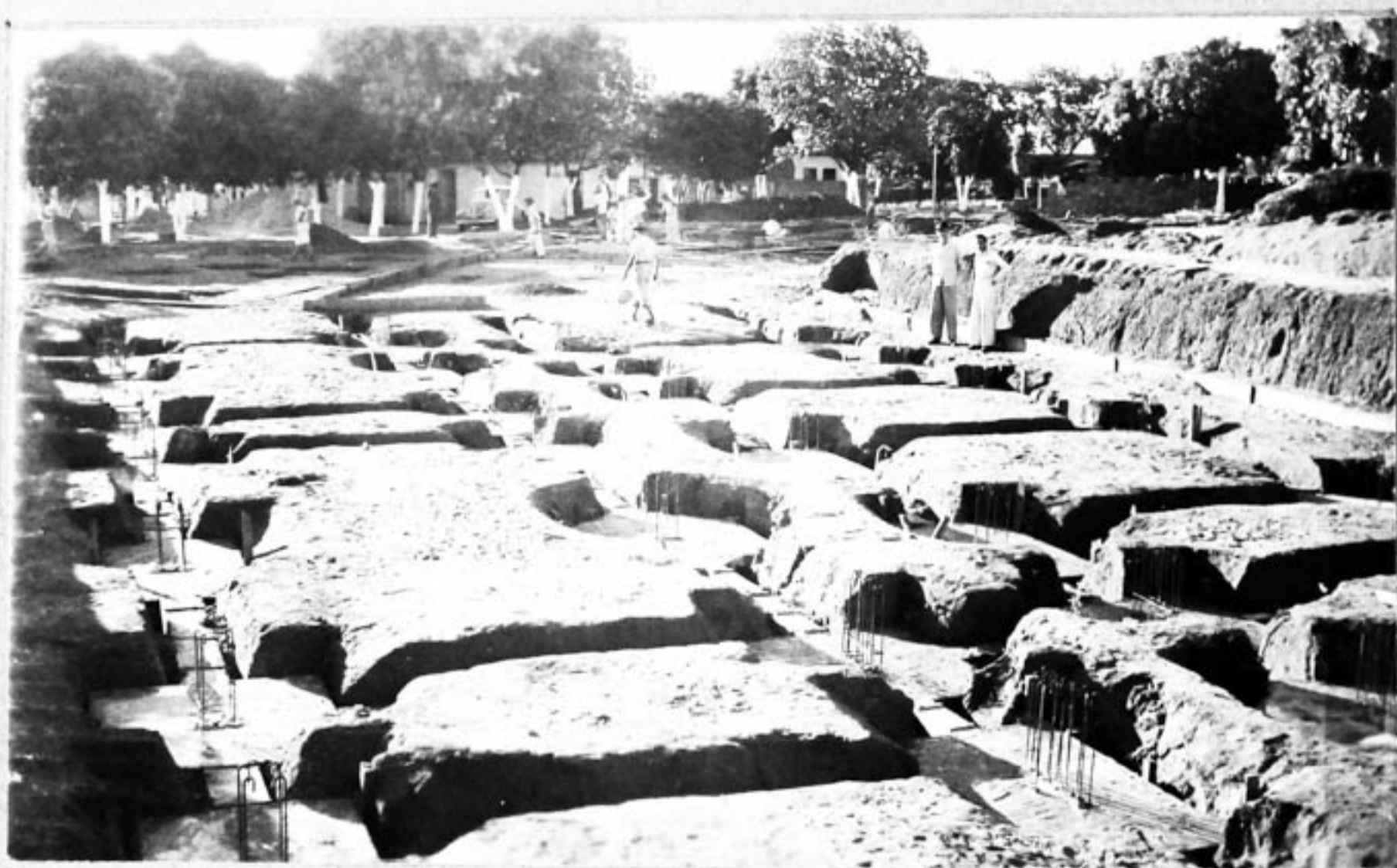
Foto 8- Corpo I- Concretagem da base
