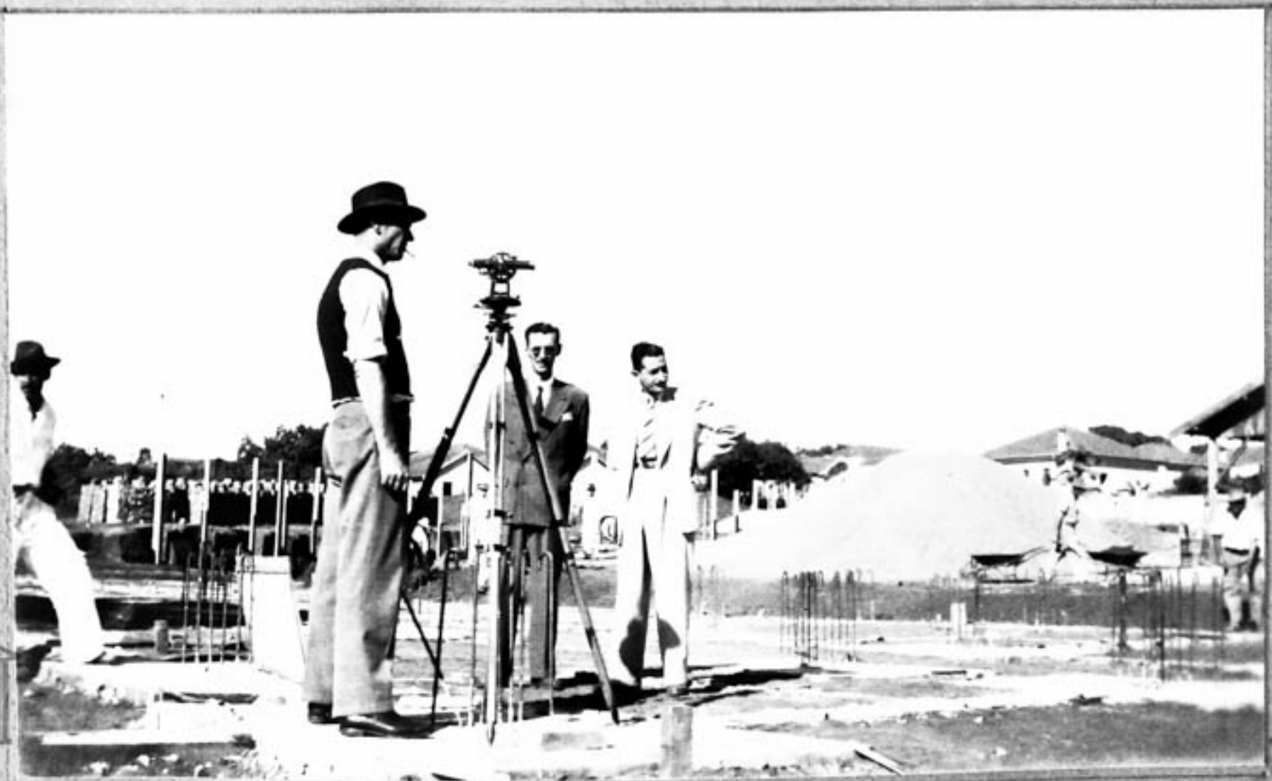
Foto 6- Locação do Corpo V
