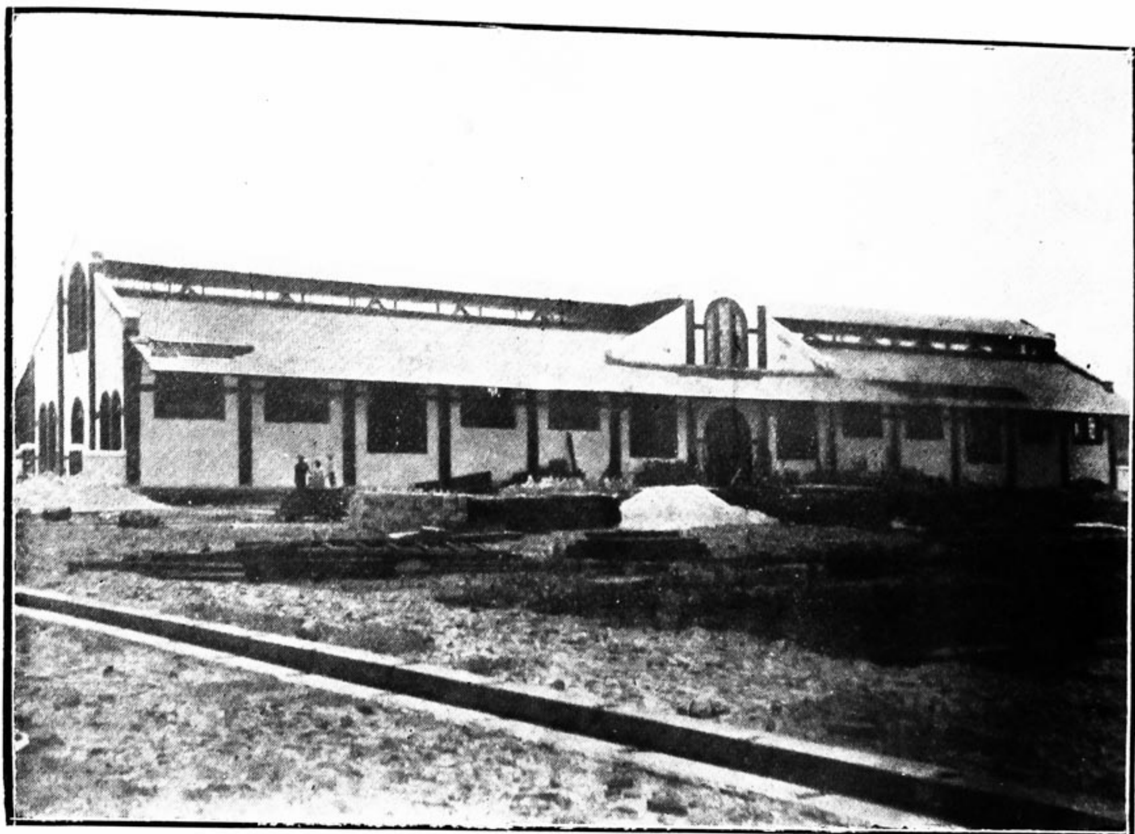
Edifício do Almojarifado em Baurú.
