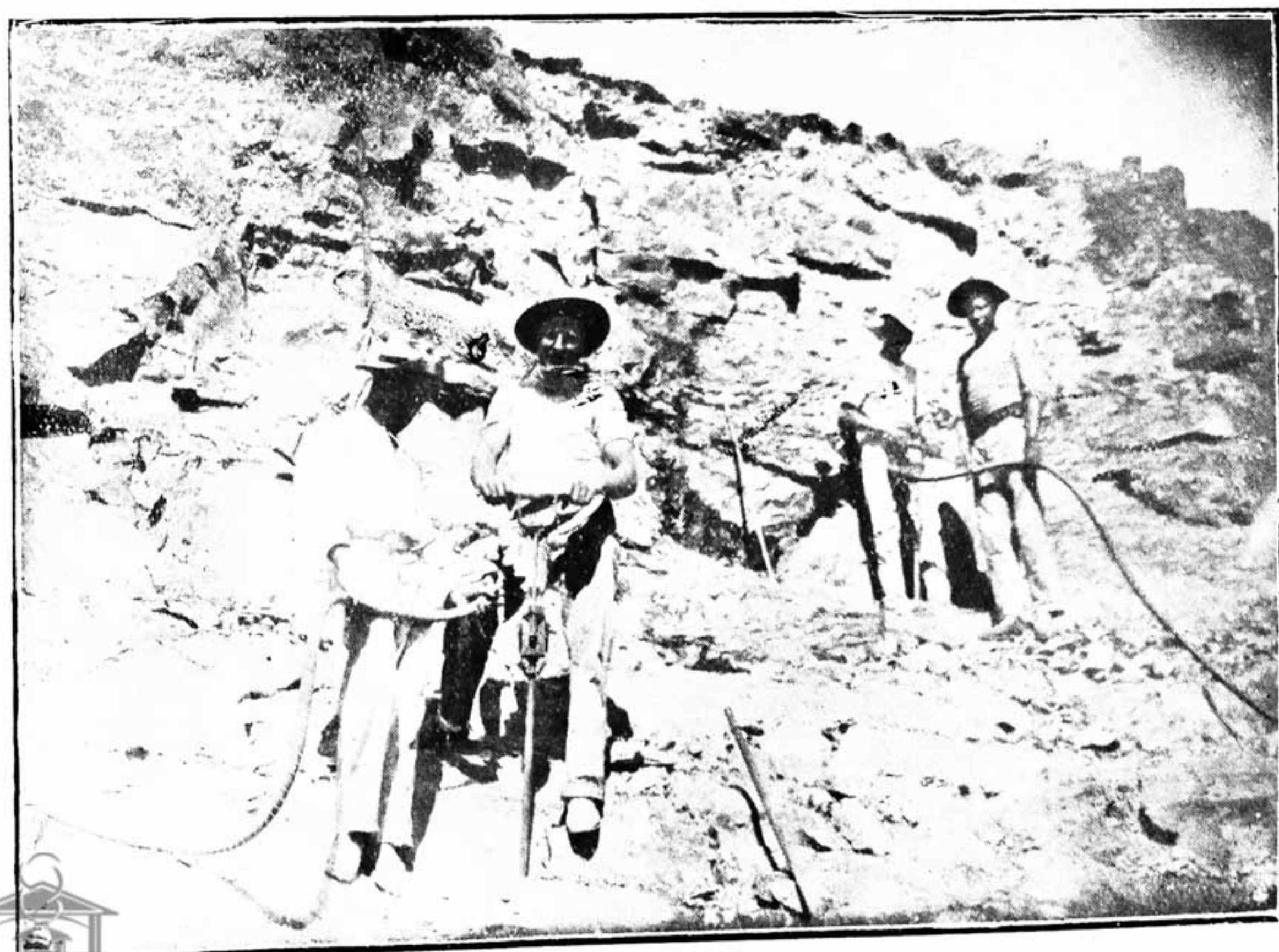
Trabalho de perfuratrizes a ar comprimido.
