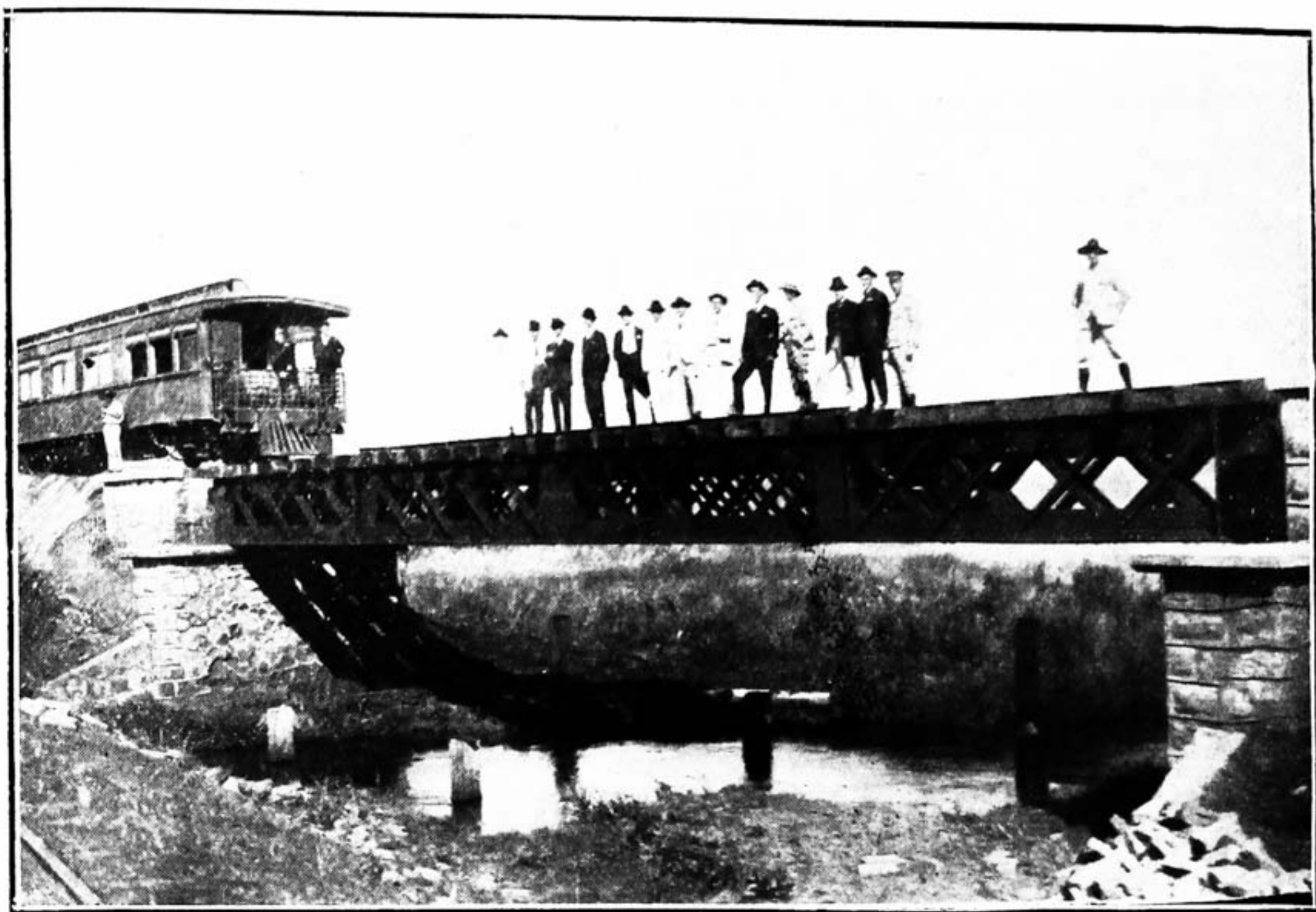
Ponte definitiva lançada sobre o Ribeirão Guabiroba. Vão de 20 metros.
