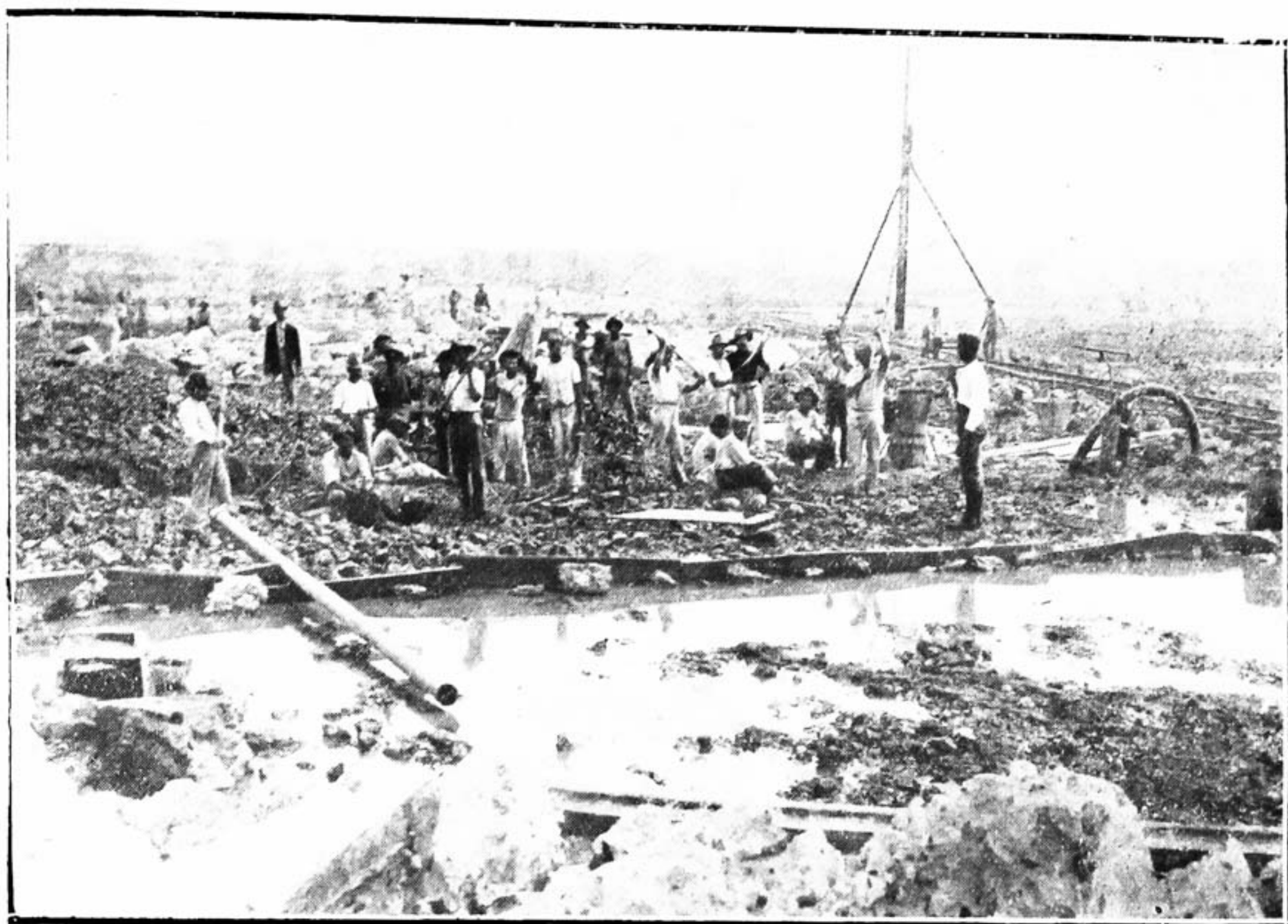
Abertura das fundações dos pilares na rocha descoberta no período da estiagem do Rio Paraná.
