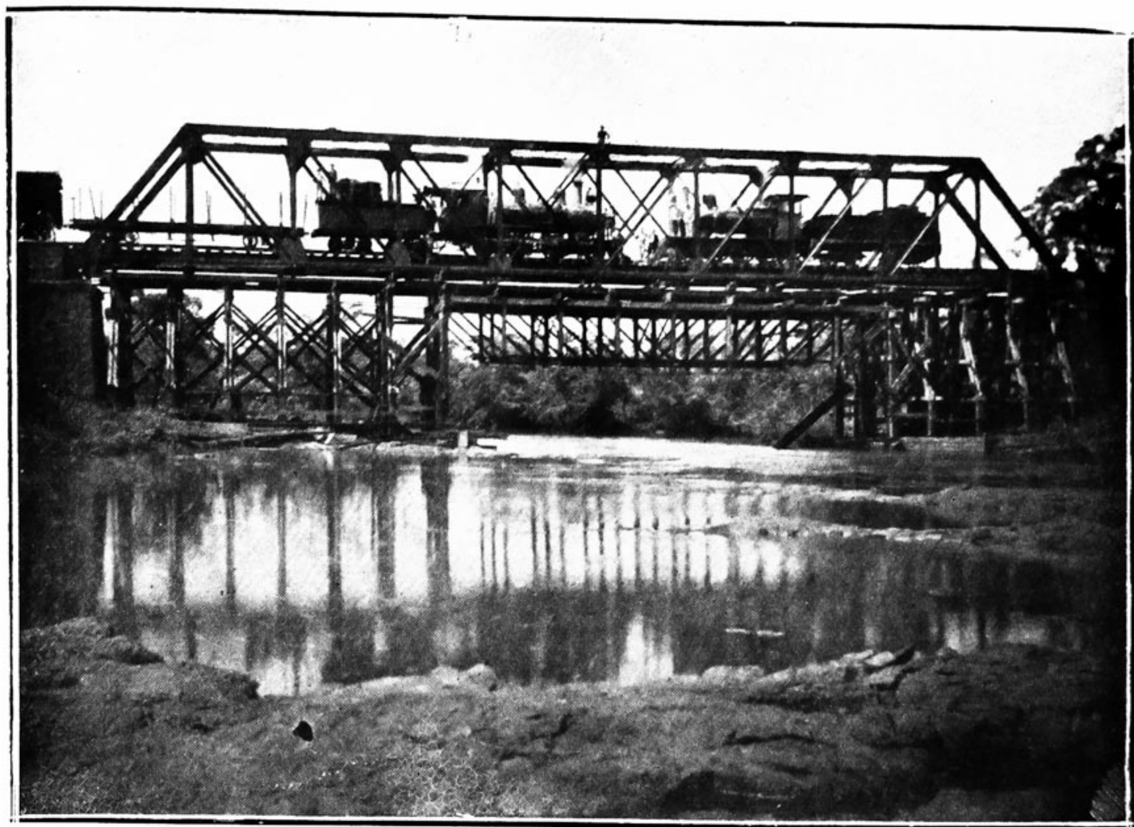
Ponte definitiva sobre o Rio Pardo, no dia da experiencia.
