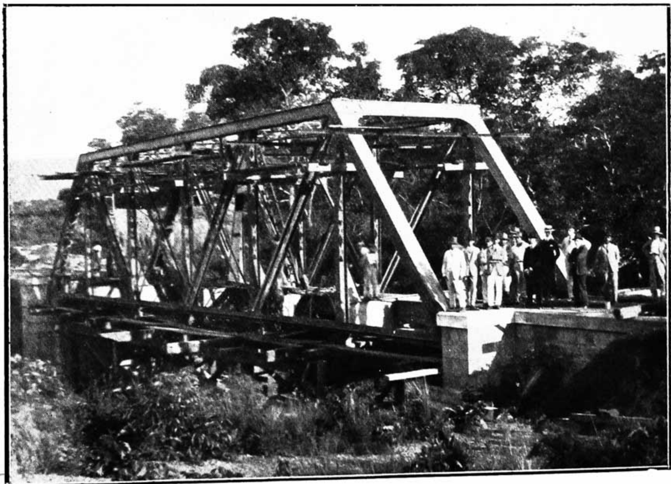
Ponte definitiva sobre o correjo das Antas, em phase de montagem.
